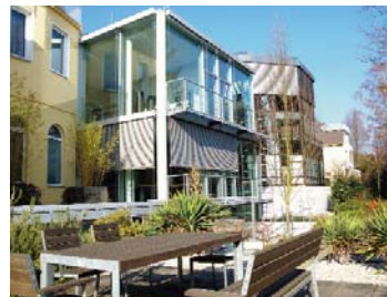
Gartenanlage Augenklinik Dardenne
